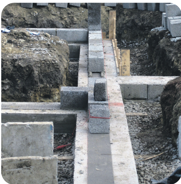
Hüdroisolatsioon vundamendi taldmiku ja plokkide vahel.
