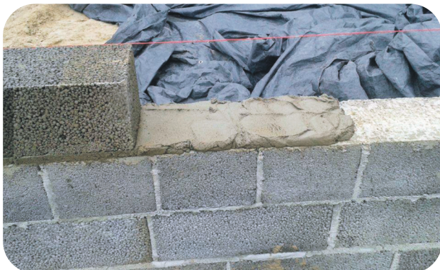
Esimene plokirida U-plokkide peal laotakse täisvuugiga. Ka U-plokkid tuleb toetada 100% nakkega alumisele plokikihile.
