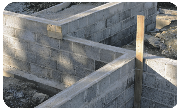
Pärast U-plokkide armeerimist betoneeritakse vundamendi ülemine tsoon.
