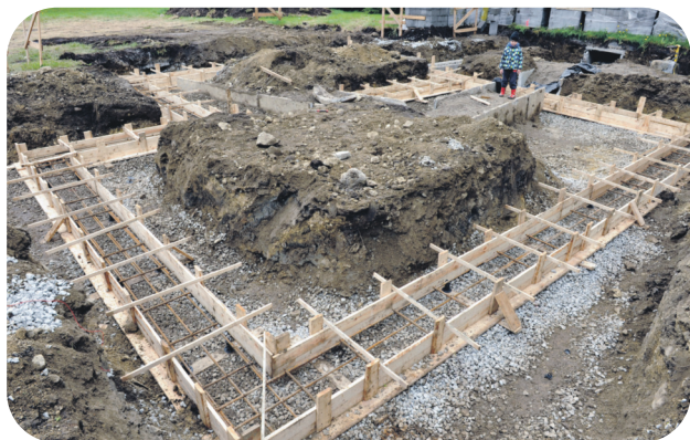
Raketised monoliitse vundamendi taldmiku ehitamiseks.
