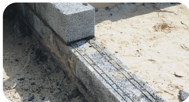
Bi-armatuur tuleb ladumise käigus kergitada segukihi sisse.
