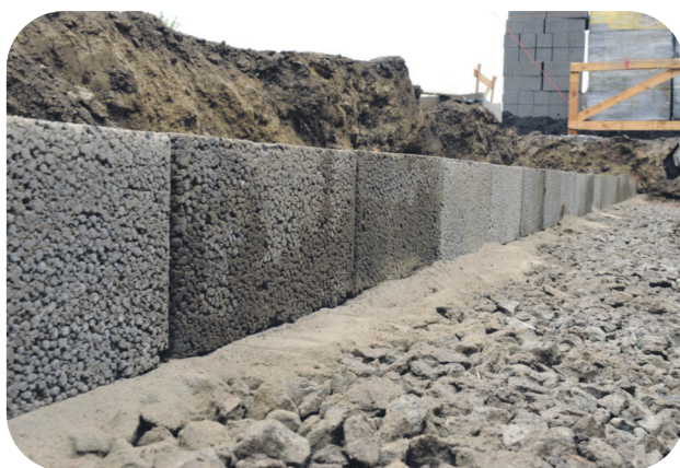
Fibo taldmikuplokkid paigaldatakse eelnevalt tasandatud killustik- alusele, millele tehakse liivast või müürisegust õhuke sängituspind.
