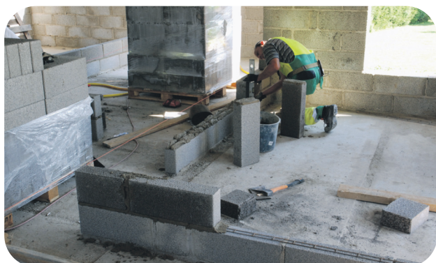
100 ja 150 mm seinte ehitamisel pannakse vuuki ainult 1 rida bi-armatuuri.
