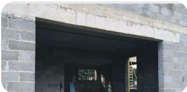
Alates 2,5meetristest avadest peab tegema betoonist sillused.
