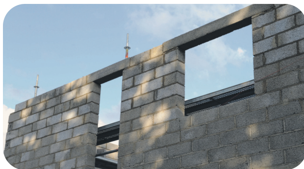
Kuni 2,5 m avade sildamiseks saab kasutada Fibo silluseid.
