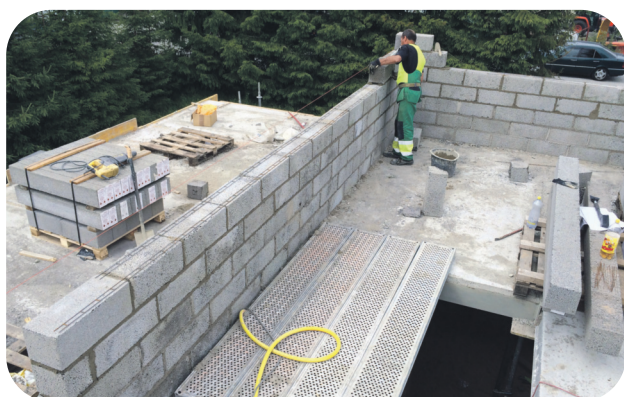
Alateest 200 mm paksusest seinast pannakse vuuki 2 rida bi-armatuuri.
