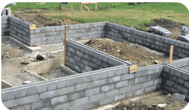
Vundamendile betoonvöö tegemiseks on lihtne kasutada Fibo U-plokke – need laotakse üksteise järel ritta. Vertikaalvuugid võib jätta ka seguga täitmata.
