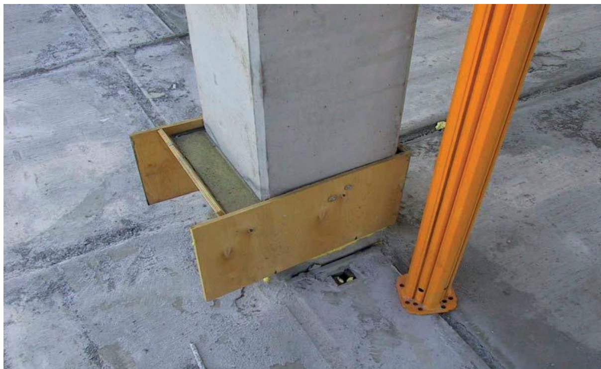
Pilt 12. Konstruksioonelemendi monolitiseerimisel kasutatav raketis
