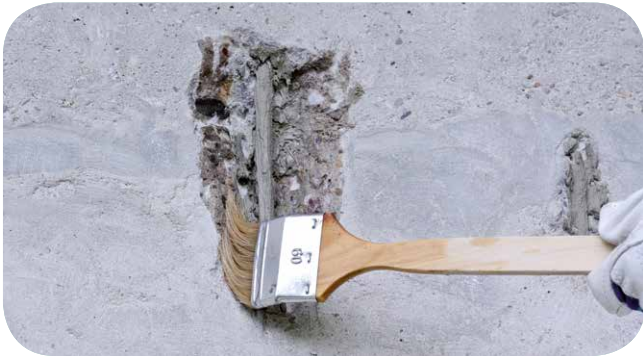
Kata armatuur korrosioonikaitsevõõbaga weber.vetonit REP 05.
