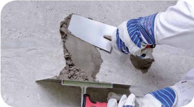
Täida betoonis olevad augud remontbetooniga (weber.vetonit REP25+/REP45/REP65) ja tasanda betoon võimalikult ühtlaseks.
