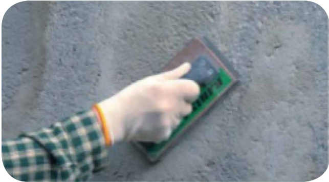
Kuivamisjärgselt eemalda lihv kiviga betoonijäägid ning niisuta enne tasandamist.
