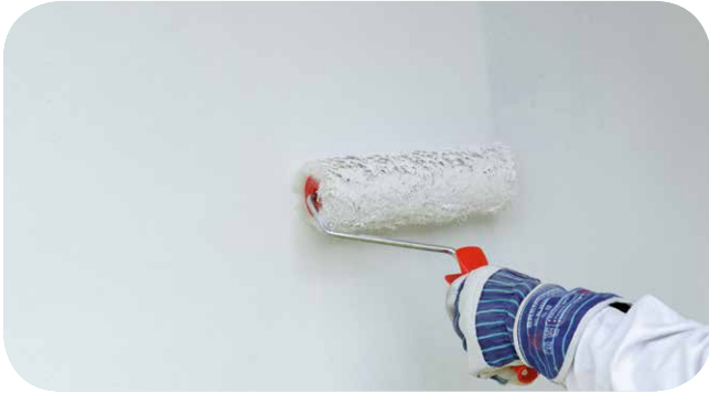
Lõpuks viimistle pind betoonikaitsevõõbaga weber.tec 771.
