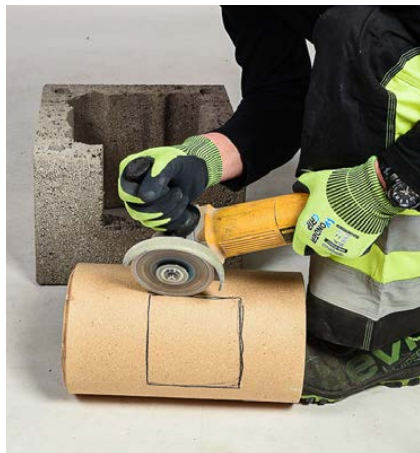
Ketaslõikuriga lõigatakse šamott-torusse sobiv ava.
