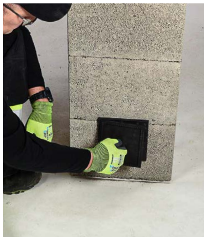
Paigaldatakse tahmaluuk, veendutakse, et see oleks tugevalt kinni.
