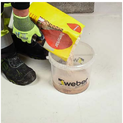
Šamott-torud liimitakse tulekindla seguga weber Fire Mortar.
