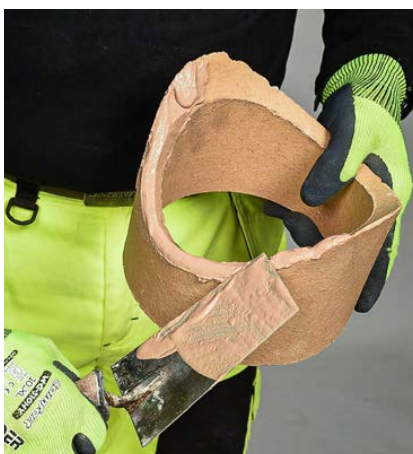
Tulekindel segu kantakse lisaühendustoru servadele.
