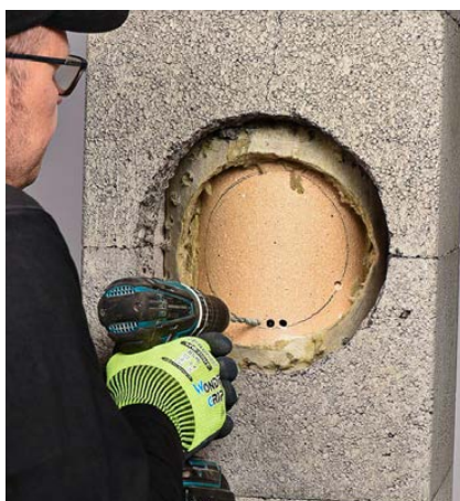
Šamott-torusse lõigatakse vajalik ava. Kuna šamott-toru on habras, tuleb vältida tugevaid lööke.
