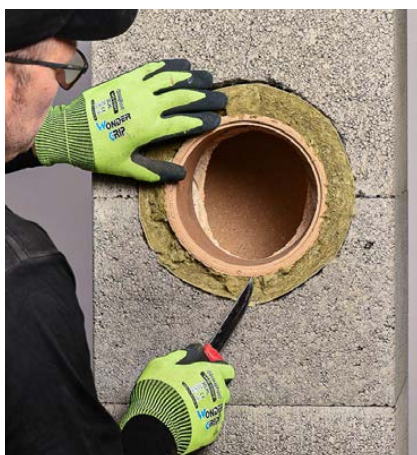
Lisaühendustoru ümber paigaldatakse vill ja viimistletakse ühendus.
