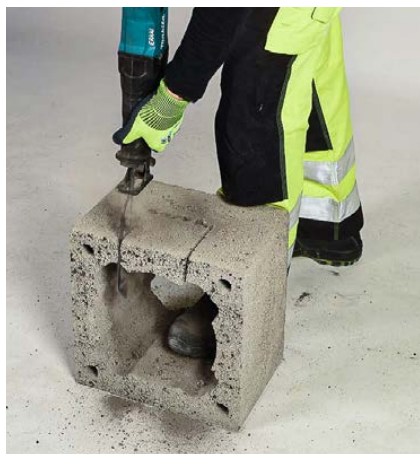
Mantelplokki lõigatakse mõõdetud ava.
