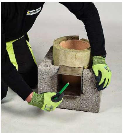
Kasutades tahmaluugi metallhülssi, kantakse mõõdud šamott-torule.
