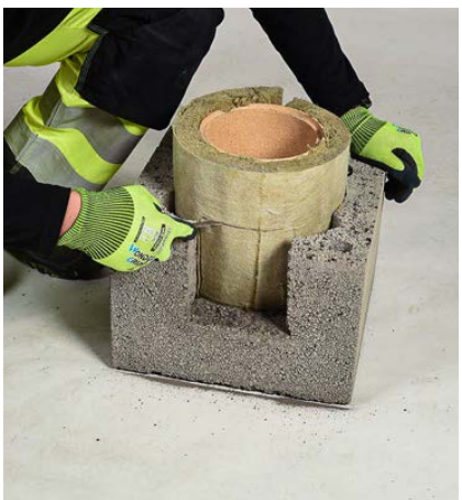
Paigaldatakse šamott-toru ja vill. Villale kantakse mõõdud ja lõigatakse villale vajalik ava.
