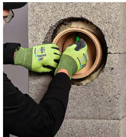
Ühendustoru abil märgitakse vajalik ava mõõt šamott-torule.
