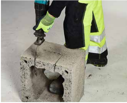
Mantelplokki lõigatakse mõõdetud ava.
