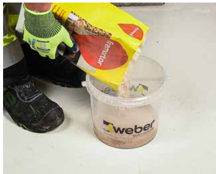
Šamott-torud liimitakse tulekindla seguga weber Fire Mortar.
