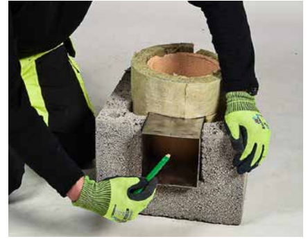
Kasutades tahmaluugi metallhülssi, kantakse mõõdud šamott-torule.
