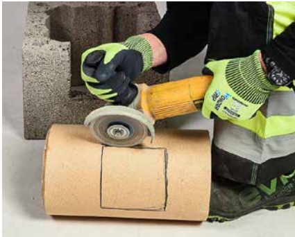
Ketaslõikuriga lõigatakse šamott-torusse sobiv ava.
