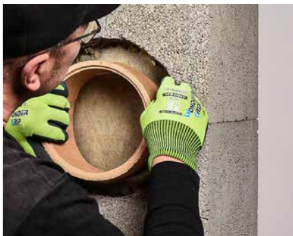
Ühendustoru abil kantakse mõõt villale.
