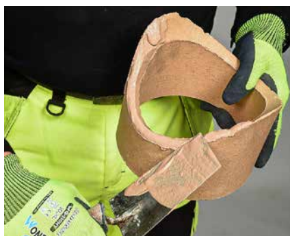
Tulekindel segu kantakse lisaühendustoru servadele.
