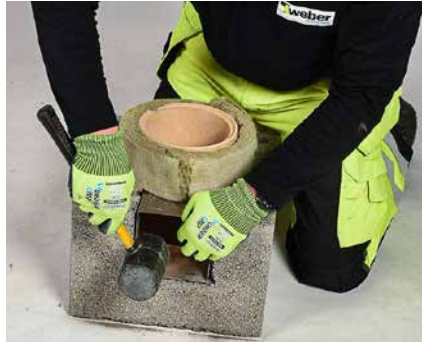
Paigaldatakse šamott-toru ja vill. Tehtud avasse sobitatakse metallist hülss.
