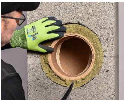
Lisaühendustoru ümber paigaldatakse vill ja viimistletakse ühendus.
