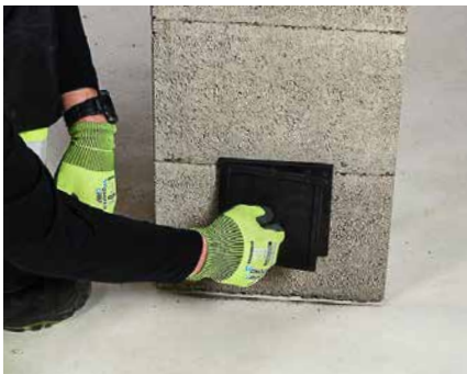
Paigaldatakse tahmaluuk, veendutakse, et see oleks tugevalt kinni.
