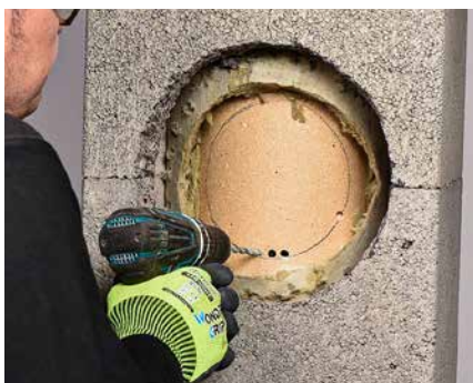
Šamott-torusse lõigatakse vajalik ava. Kuna šamott-toru on habras, tuleb vältida tugevaid lööke.
