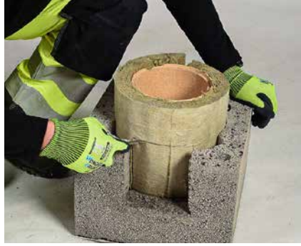
Paigaldatakse šamott-toru ja vill. Villale kantakse mõõdud ja lõigatakse villale vajalik ava.
