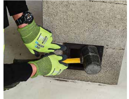
Paigaldatakse järgmine mantelplokk ja veendutakse, et hülss sobitub korrektselt kohale.
