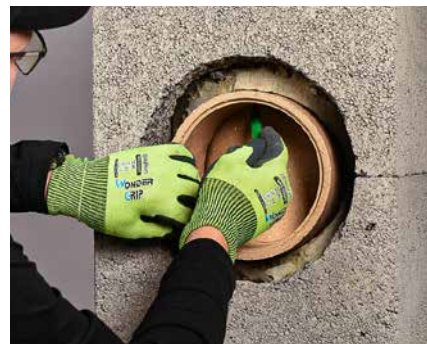
Ühendustoru abil märgitakse vajalik ava mõõt šamott-torule.
