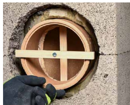
Lisaühendus fikseeritakse šamott-toru külge, kasutades selleks kohandatud puidust fiksaatorit.
